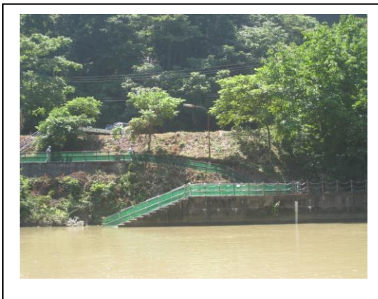
整備された大牧発電所船着場
