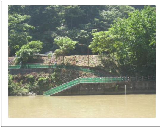
整備された大牧発電所船着場
