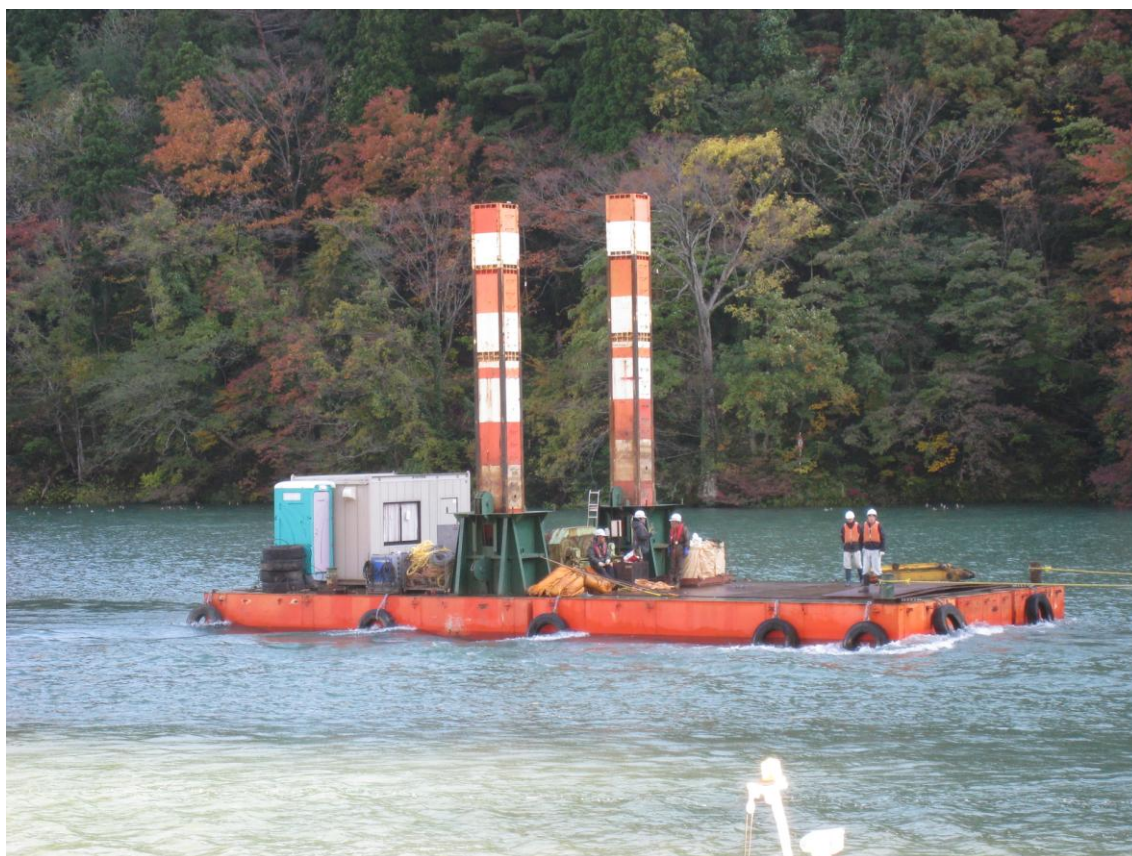
運ばれていく浚渫工事機材
